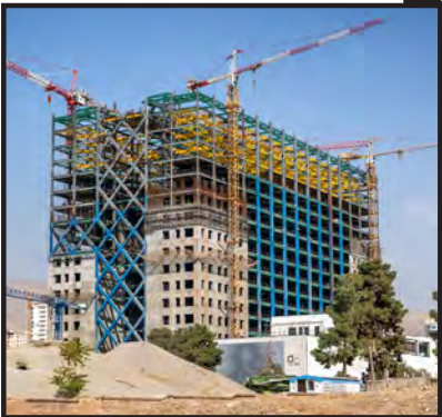
..... [اسکلت سازه فلزی بیمارستان سلامت برکت]
