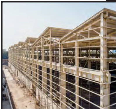
..... [اسکلت سالن پرس شاپ ۲ شرکت طراحی و ساخت قطعات صنایع ایران]
