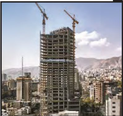
..... [اسکلت فلزی پروژه هتل بین‌المللی ملل]
