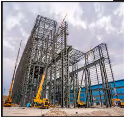
..... [اسکلت فلزی کارخانه ذوب مجتمع تولیدی فولاد سپید فراب کویر]
