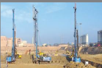
پروژه تحکیم بستر یوشهر
