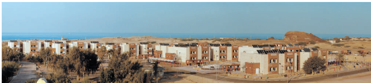
• ساختمان‌های مسکونی کوی نصر در جزیره سیری
