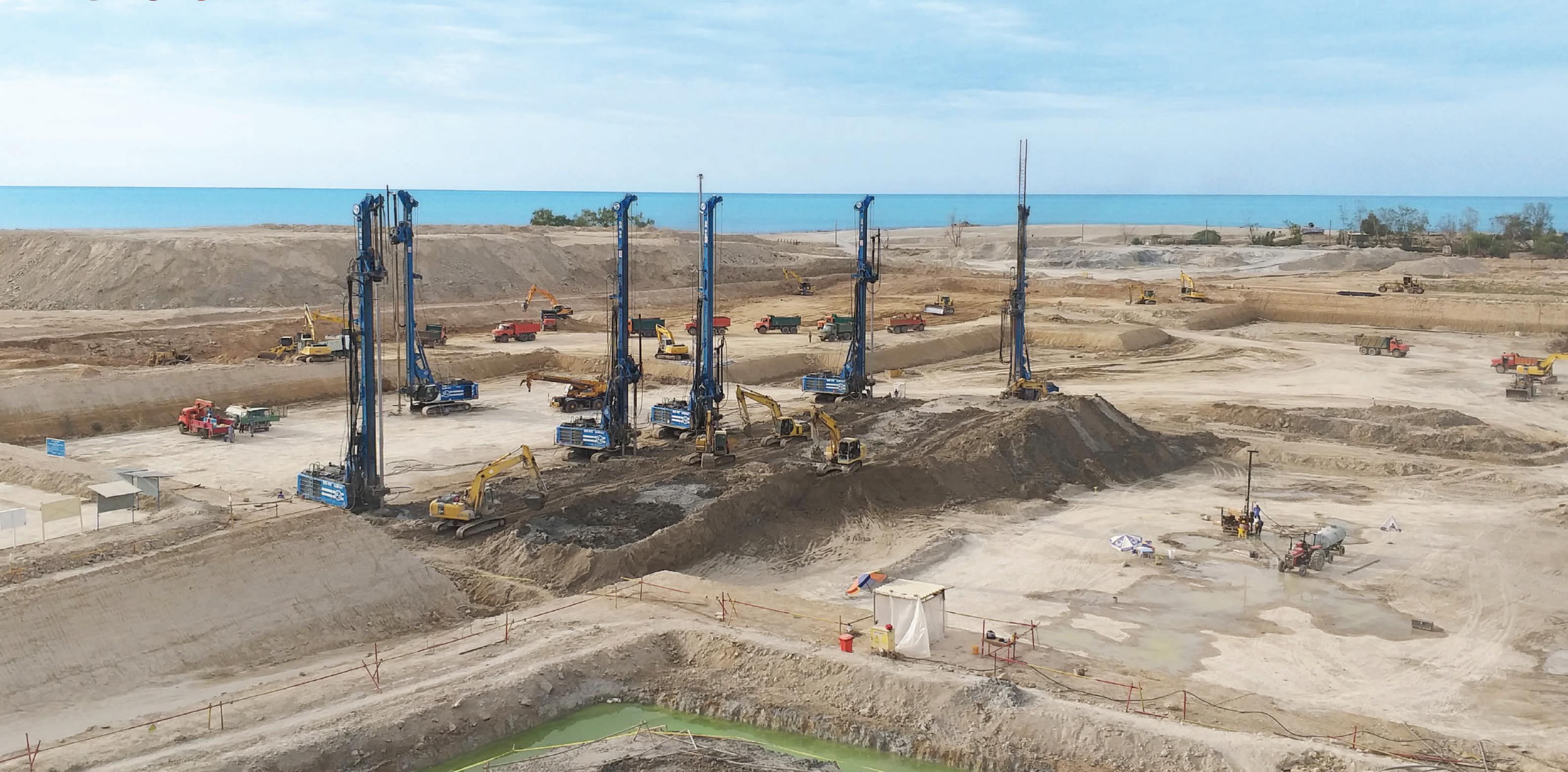
• پروژه تحکیم بستر بوشهر
