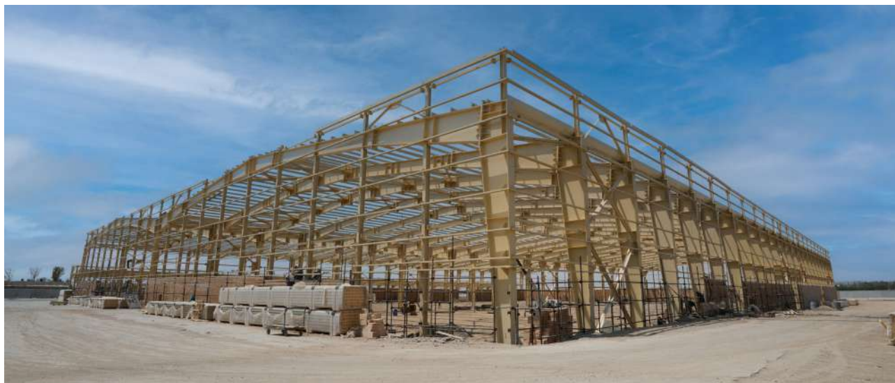
• سازه‌های فلزی سوله شماره ۸ کارخانه شماره ۲ بهمن موتور | ۱۴۵۰ تن
