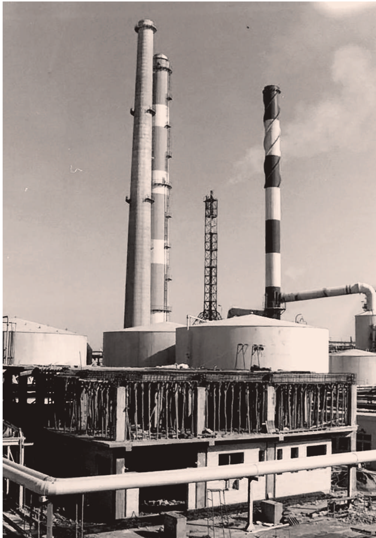
• ساختمان کنترل شرکت پتروشیمی رازی
