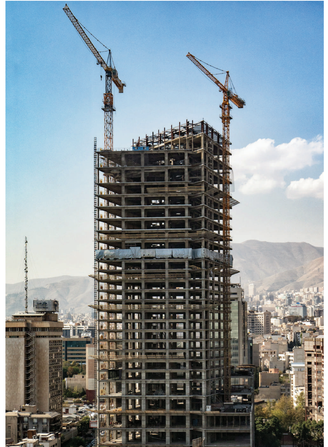
• ساخت سازه‌های فلزی پروژه هتل ملل | ۱۶۰۰۰ تن
