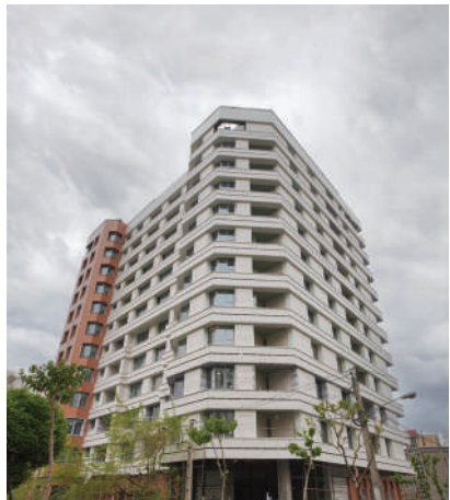
• مجتمع مسکونی ۴۲ واحدی آجودانیه
