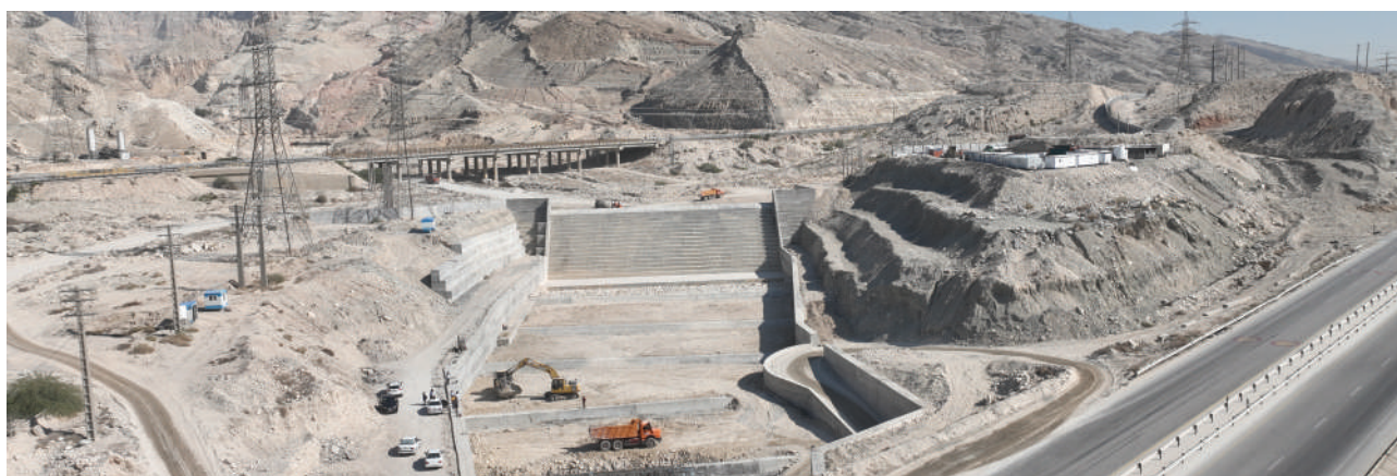
• سد بتنی تثبیت بستر (Bedsill) رودخانه هنویز
