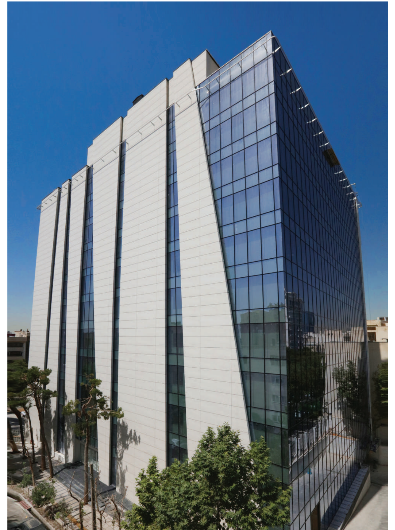
• ساختمان اداری شرکت خدمات انفورماتیک
