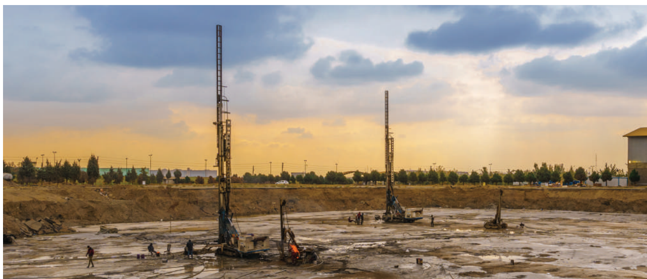
• پروژه بهسازی خاک فروشگاه زنجیره‌ای رفاه به روش جت گروت
