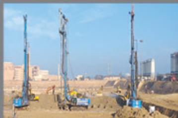
پروژه تحکیم بستر یوشهر
