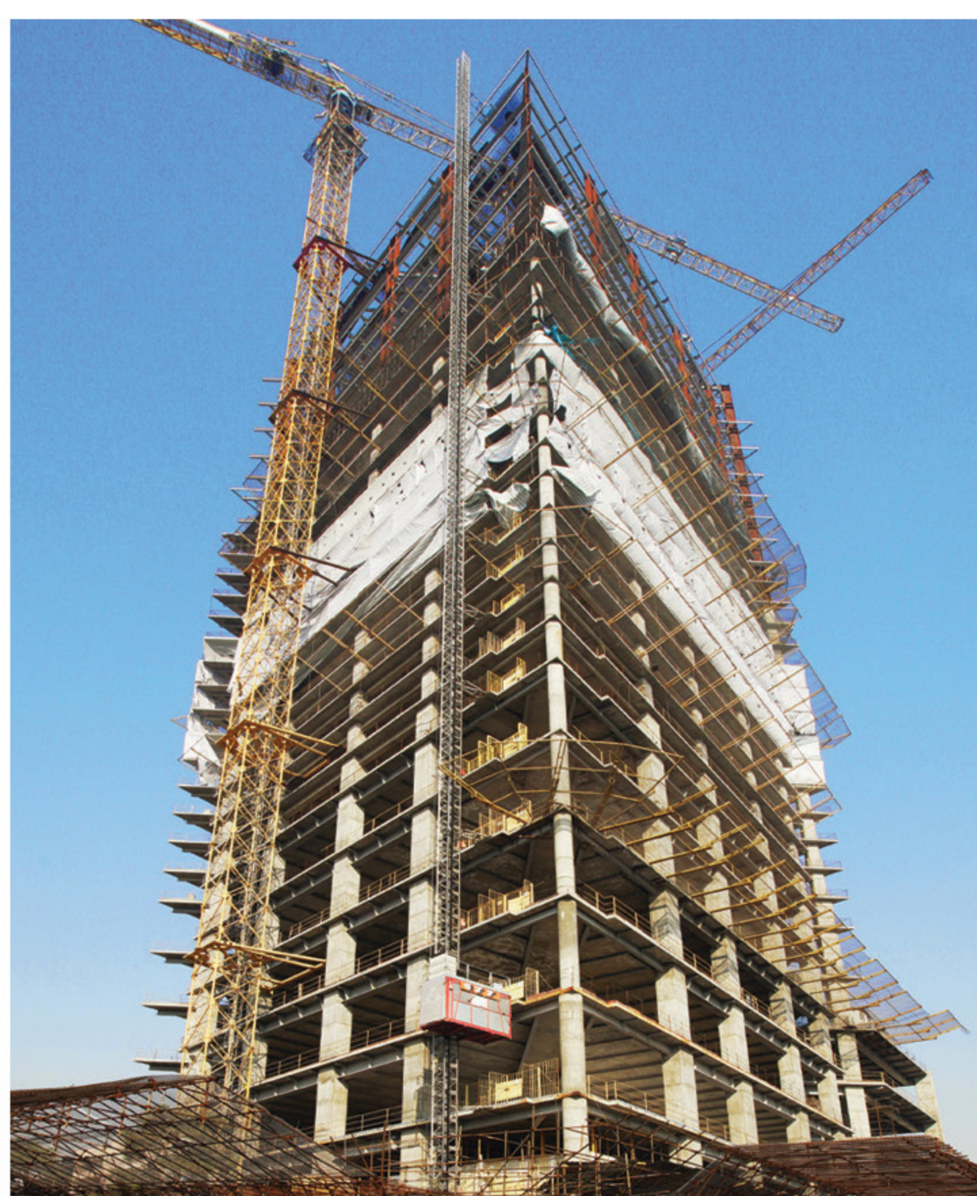
● سازه فلزی هتل ملل
