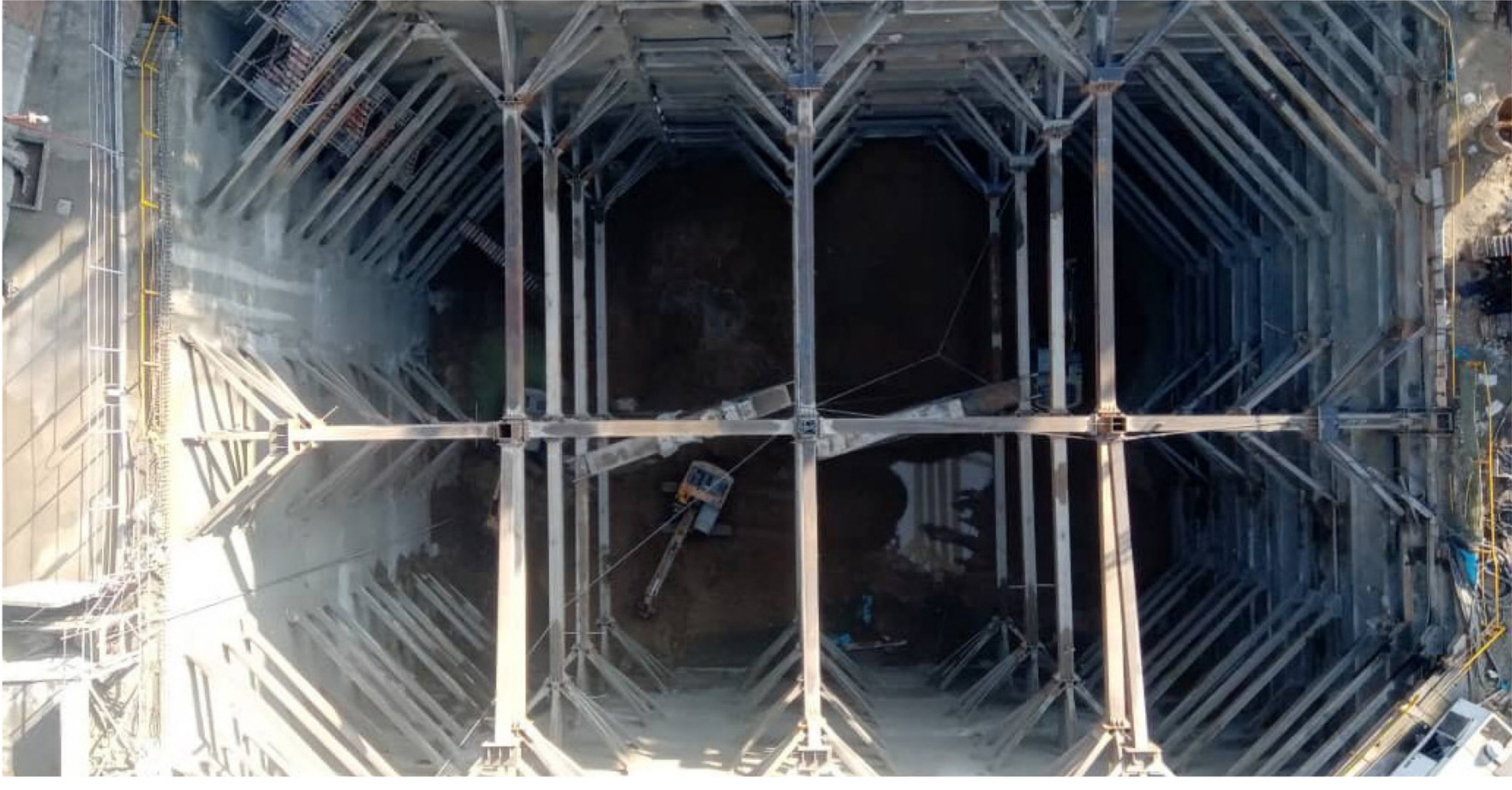
● پایدارسازی پروژه ی دیپا به روش مهار متقابل
