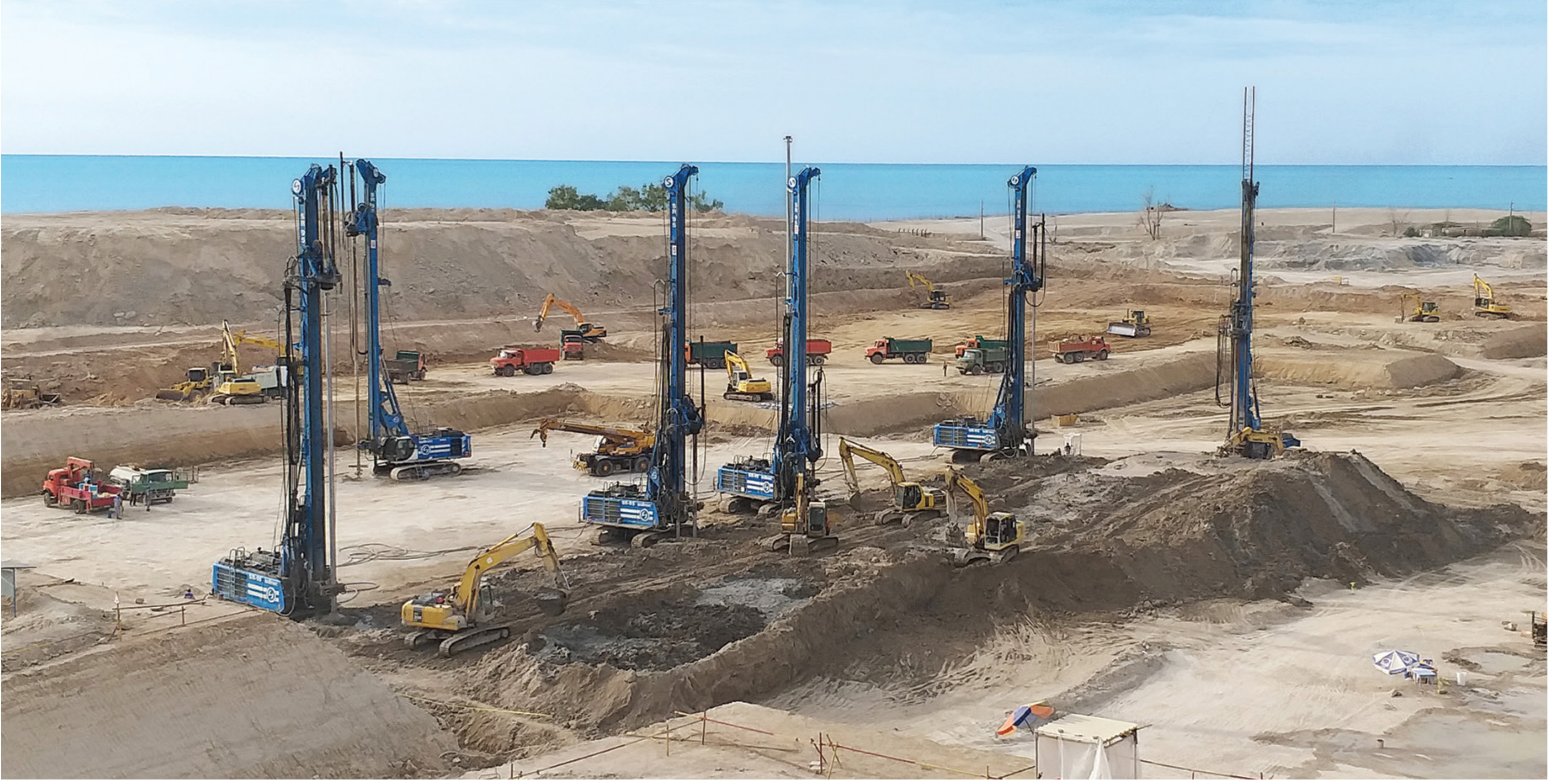
● پروژه تحکیم بستر بوشهر
