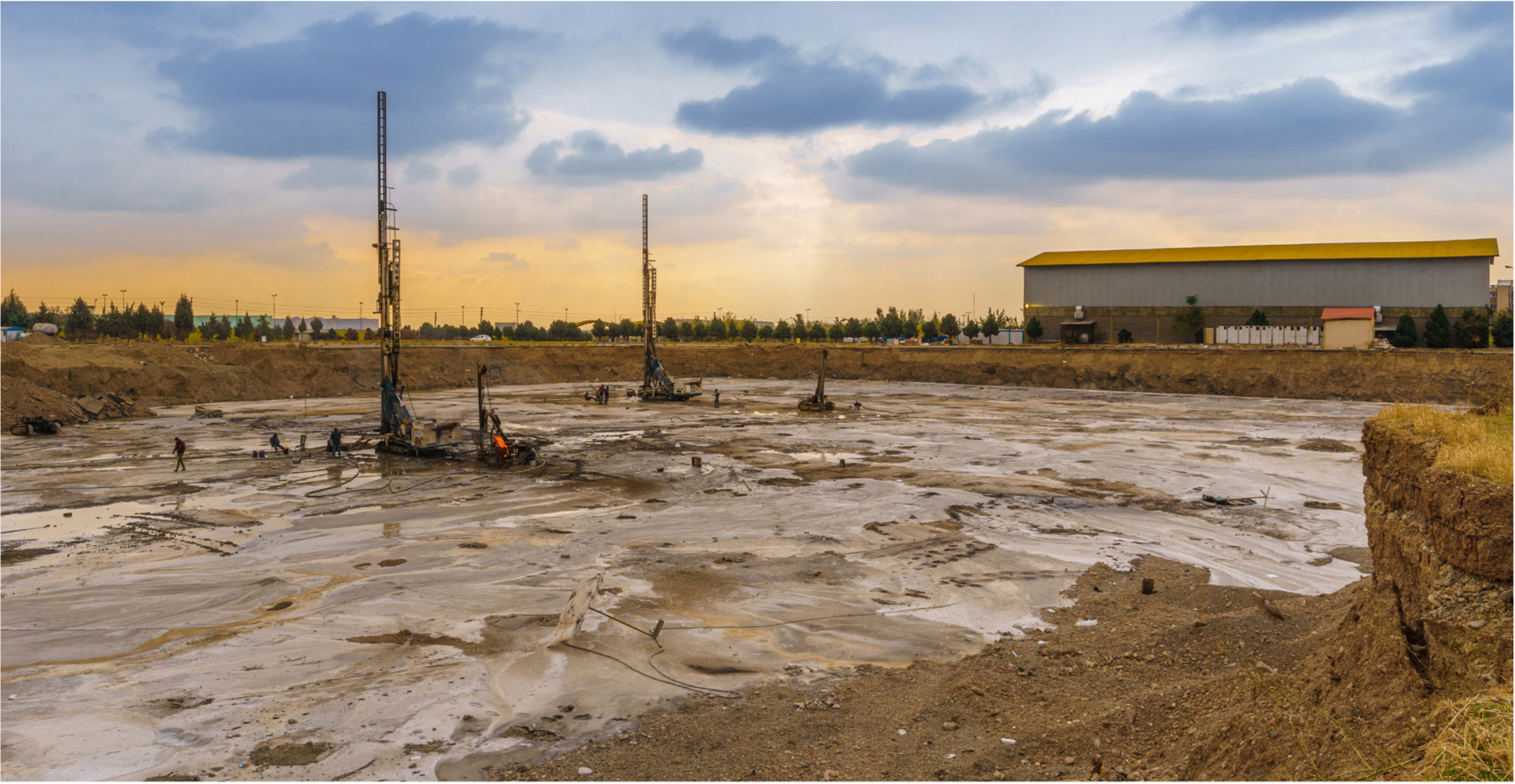
● پروژه بهسازی خاک فروشگاه زنجیره ای رفاه به روش جت گروت
