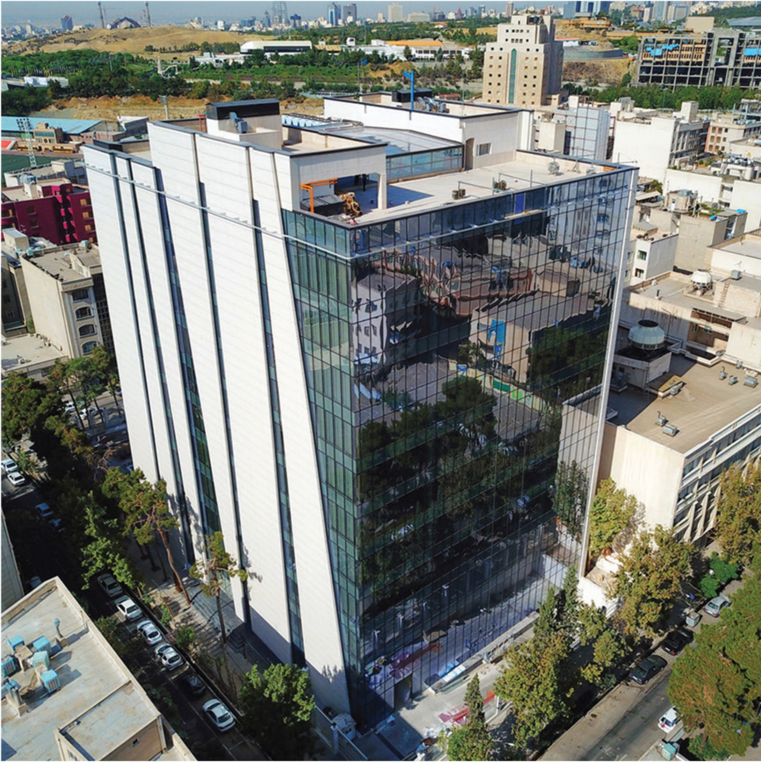
● ساختمان اداری شرکت خدمات انفورماتیک
