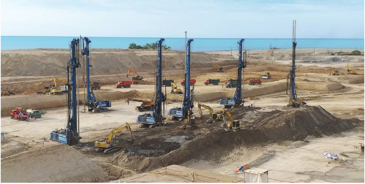
● پروژه تحکیم بستر بوشهر
