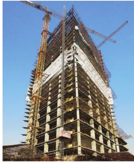
● سازه فلزی هتل ملل
