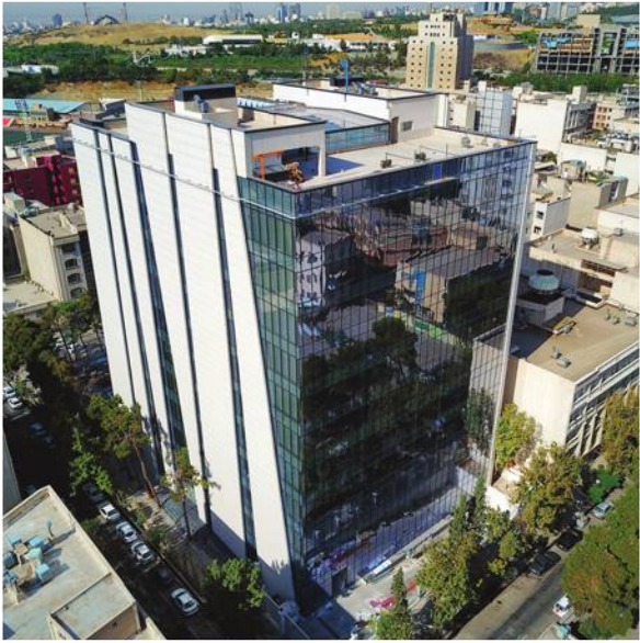
● ساختمان اداری شرکت خدمات انفورماتیک
